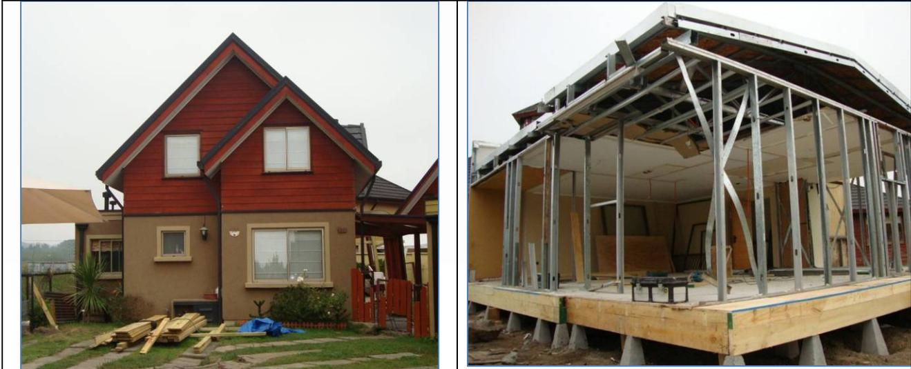
Fotografías 11 y 12. Ejemplo de construcción de viviendas con el sistema estructural Metalcon - municipalidad de San Pedro de la Paz
